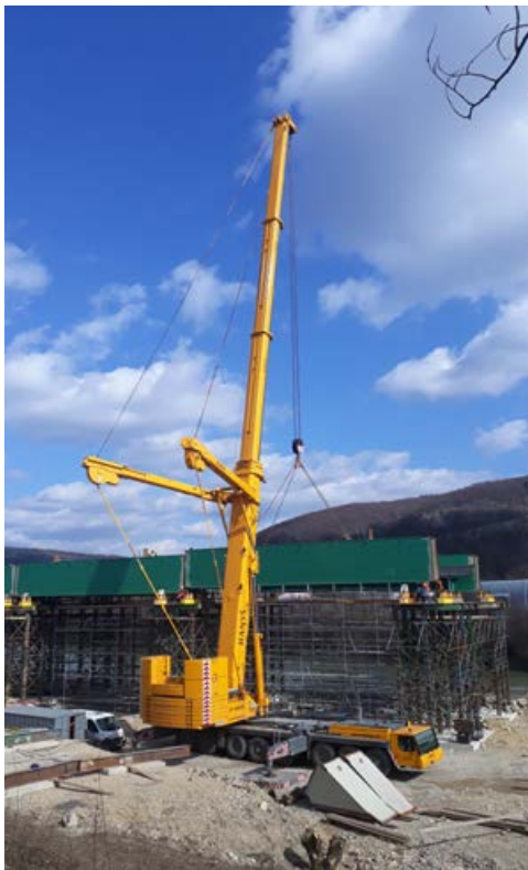
Obr. 3 – Montáž ocelevej nosnej konštrukcie NK3 – komorové trámy
