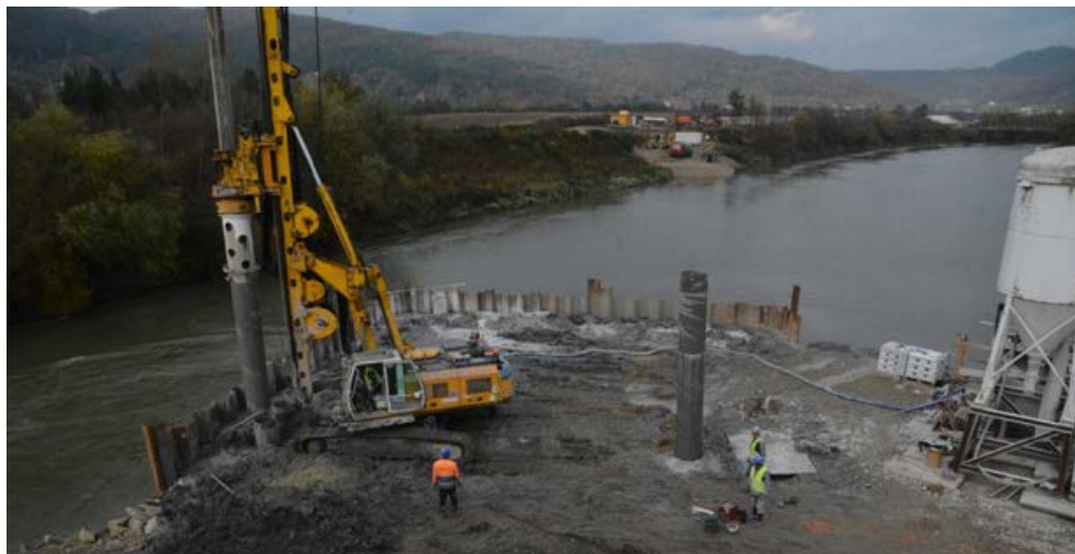
Obr. 1 – Predvrtávanie štetovnic a výplň tesniacou hmotou pre založenie piliera P3
