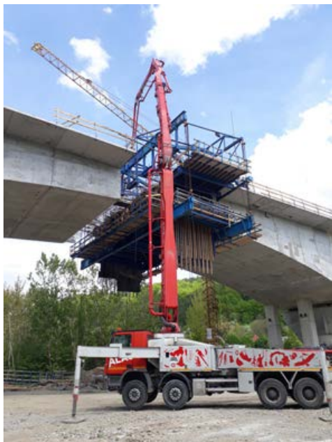
Obr. 6 – Betonáž spojovacej lamely pomocou vozíkov LB
