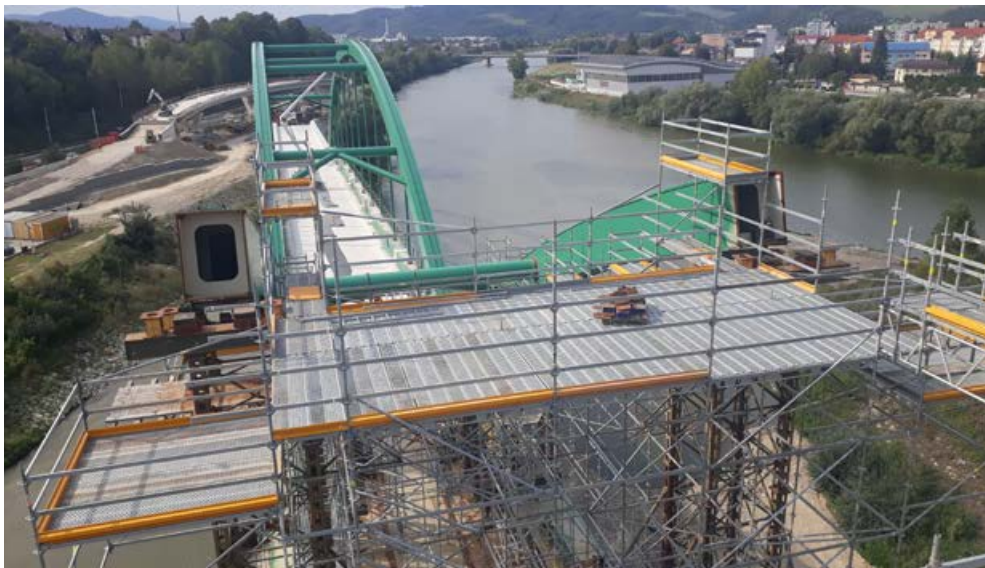
Obr. 2 – Montáž ocelevej nosnej konštrukcie NK3 – oblúky
