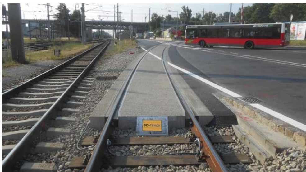
Obr. 1 – BO-TRACK, pohled na hotovou konstrukci
