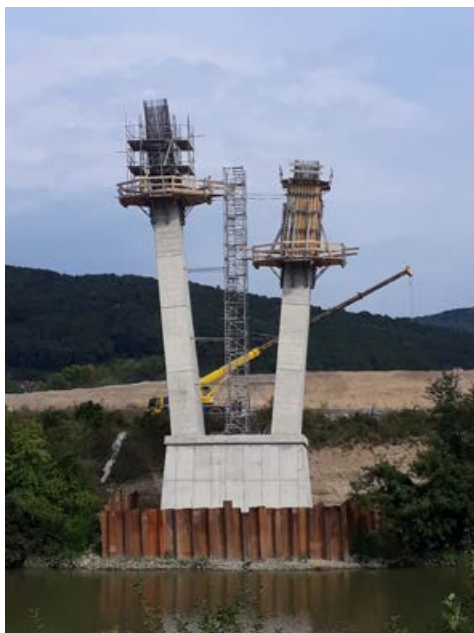
Obr. 4 – Konzolové ramená pylónu P2
