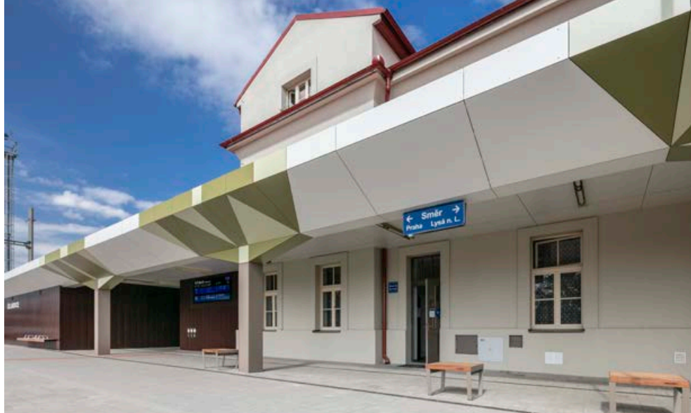
Obr. 6 – Čelákovice výpravní budova
