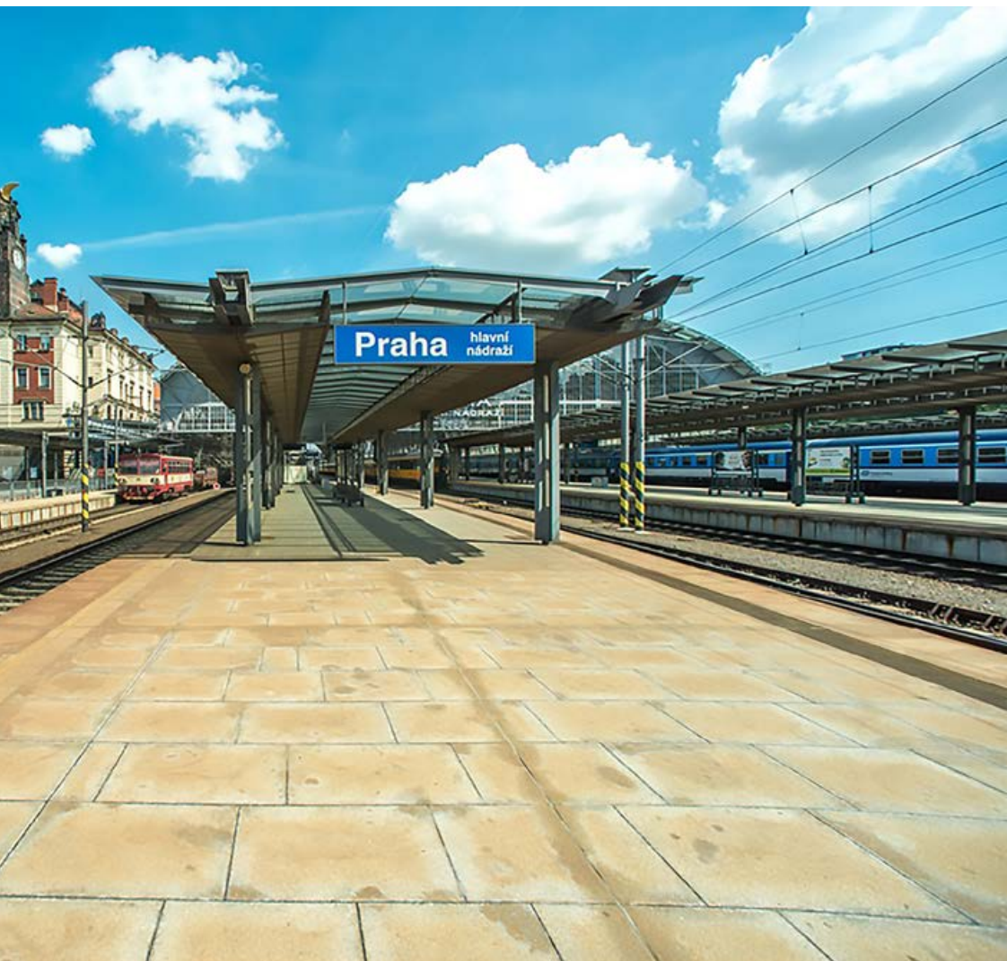
Obr. 2 – Praha hl.n. Zdroj: SŽDC
