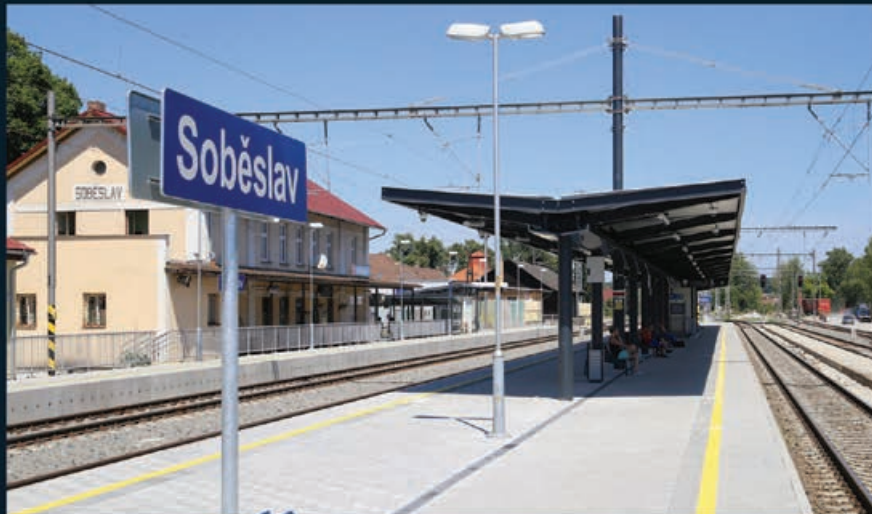
Rekonstrukce ŽST Soběslav
